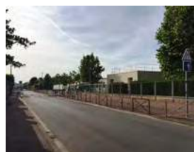
Installation de barrières fixes devant tous les sites.
