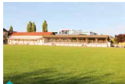
Démolition des tribunes et des bâtiments annexes en 2018
