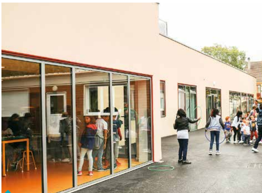
Construction d'un nouveau restaurant scolaire Victor-Hugo en 2018
