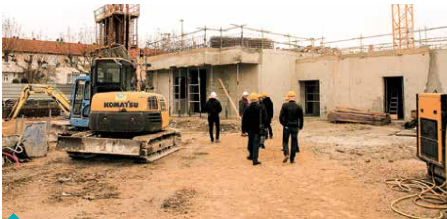
Visite du chantier du conservatoire début décembre 2018
