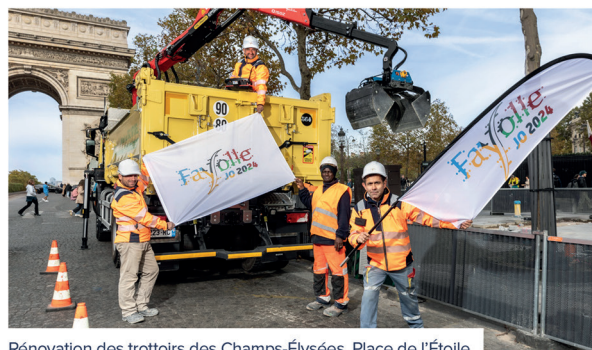
Rénovation des trottoirs des Champs-Élysées, Place de l'Étoile
